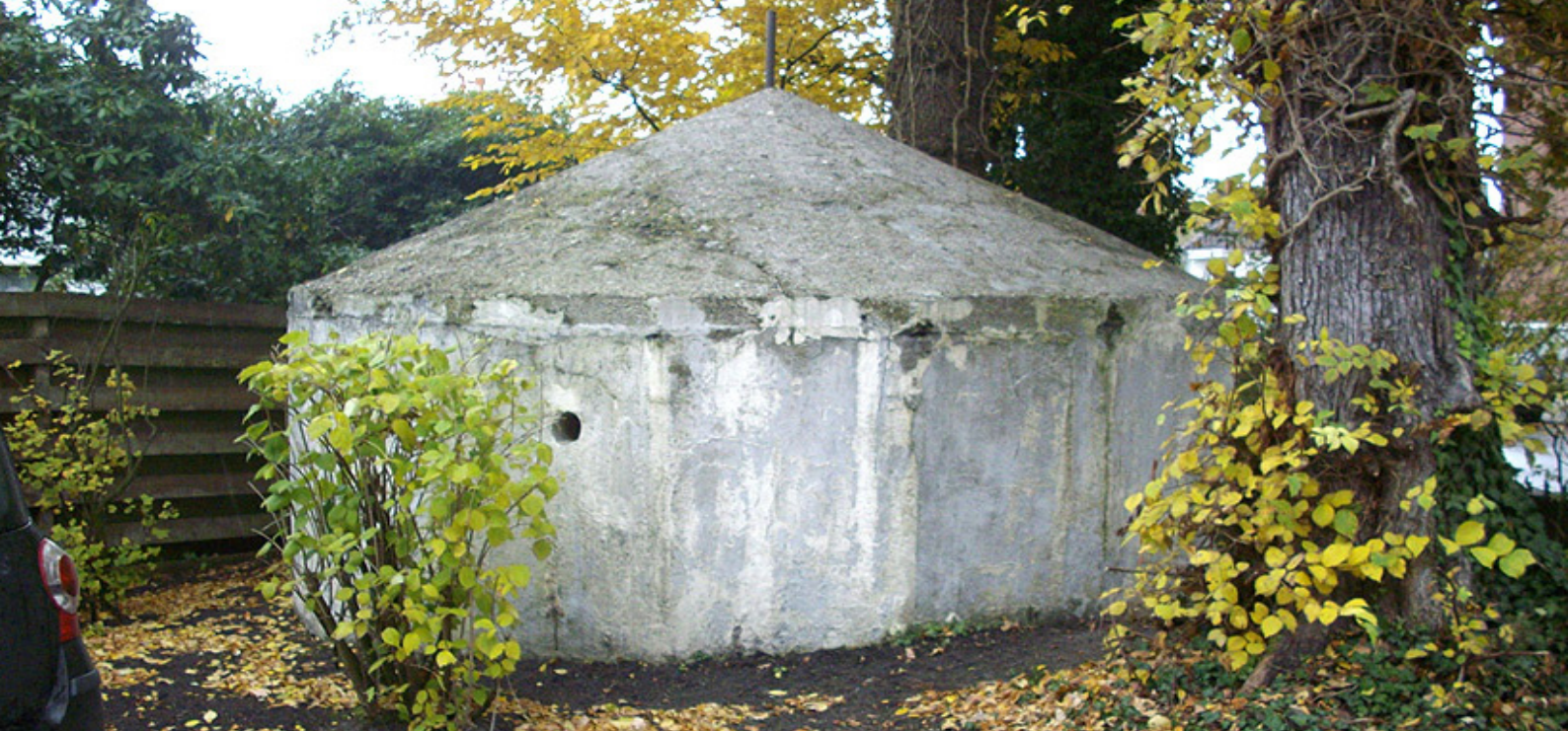
Oben: Vorschlag Baudenkmal Rundschutzbautyp Klein (R3) Bloherfelder Straße 40 Oldenburg / Unten: Vorschlag Baudenkmal Rundschutzbautyp Mittel (R2) Elsässer Straße 28 Oldenburg.
